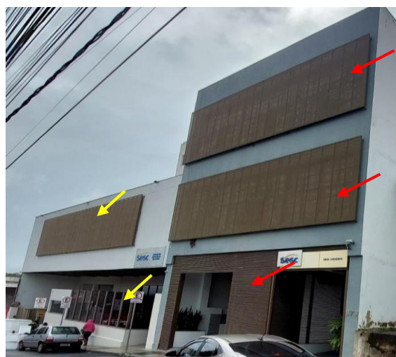
Foto 22: Brises, estruturas metálicas da entrada principal
